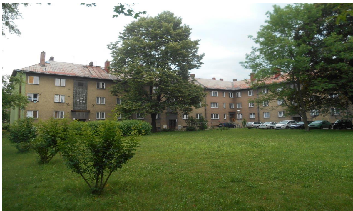
Pohled na blok domů Syllabova 26-34 v Ostravě-Vítkovcích
